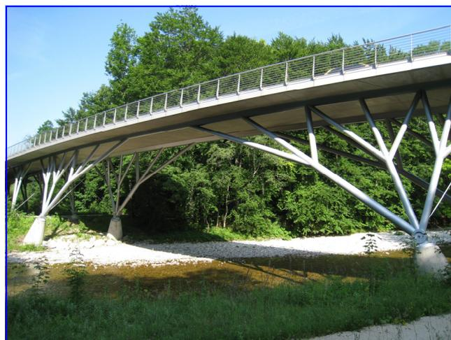
die Berechnung der angreifenden Schnittkräfte sind die Knoten in das Modell einer typischen Fachwerkbrücke eingebunden worden. Zur Verallgemeinerung dieser Ergebnisse, wurden im Anschluss Parameterstudien durchgeführt. Dabei wurde der Einfluss der Materialeigenschaften und der durch den Brückentyp bedingten Knotengeometrie und -belastung auf die maximal zulässige Anfangsgröße von Gussfehlern untersucht.
